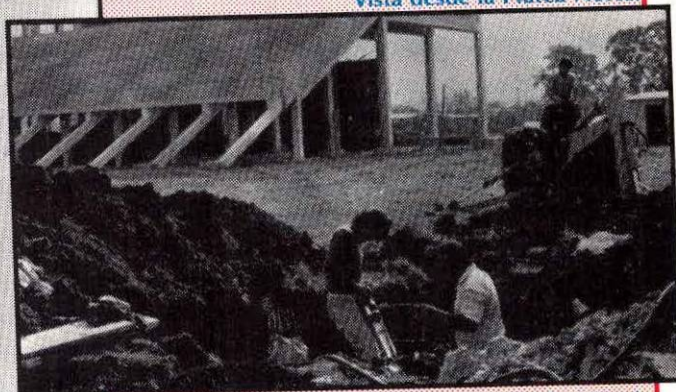
Toma 2: El personal de CIELMEC efectúa el encadenado previo a la colocación de las columnas.
